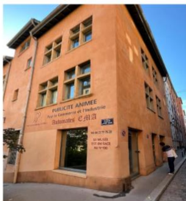
Vue du bureau depuis la rue Saint Georges
